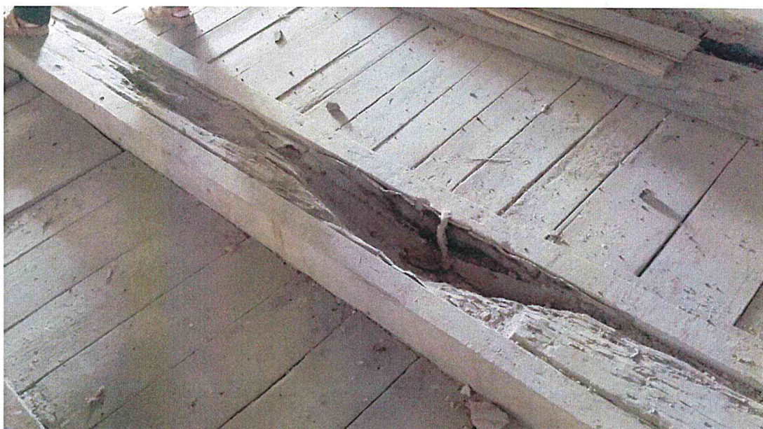
Fot. 2. Zniszczona belka; źródło własne: Łapacz Winkowski Architekci
