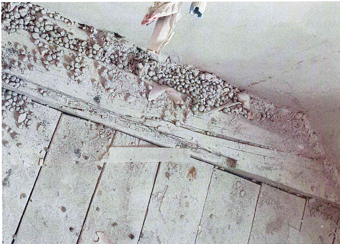
Fot. 4. Rozwarstwiona belka; źródło własne: Łapacz Winkowski Architekci; źródło własne: Łapacz Winkowski Architekci
