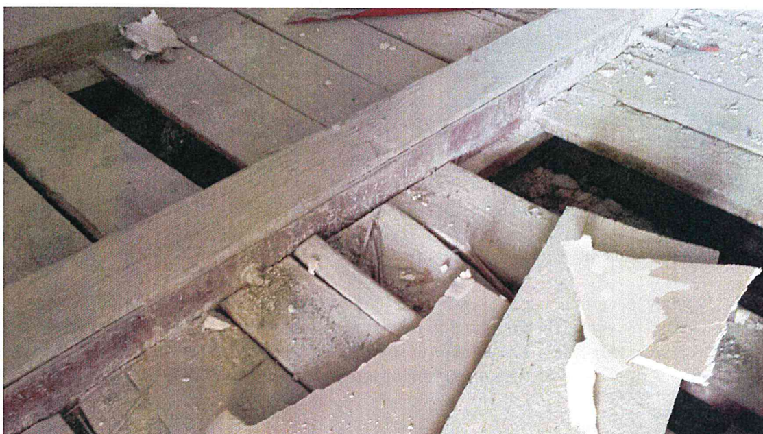
Fot. 3. Belka wzmocniona płaskownikami; źródło własne: Łapacz Winkowski Architekci
