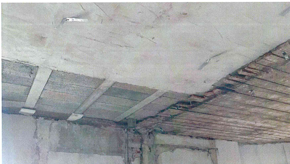
Fot. 5. Wymieniony odcinek stropu; źródło własne: Łapacz Winkowski Architekci
