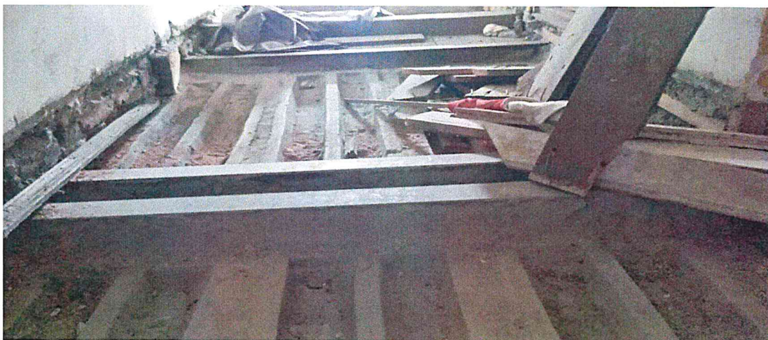
Fot. 1. Wymieniony strop drewniany na strop WPS; źródło własne: Łapacz Winkowski Architekci
