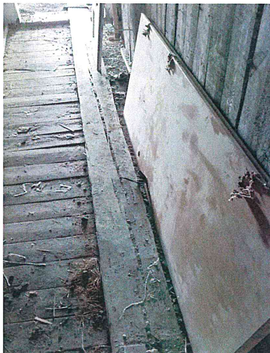
Fot. 6. Rozwarstwiona belka; źródło własne: Łapacz Winkowski Architekci
