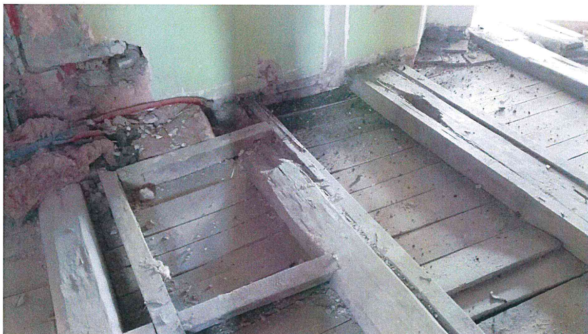
Fot. 7. Zniszczony wymian i końcówki belek stropowych; źródło własne: Łapacz Winkowski Architekci
